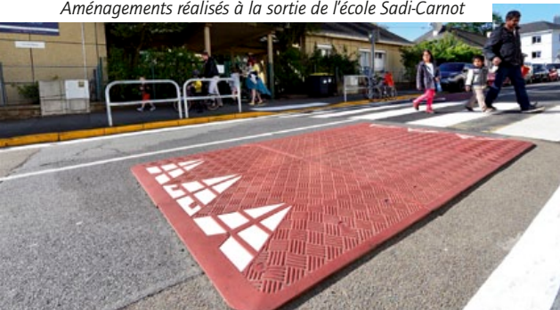
Aménagements réalisés à la sortie de l'école Sadi-Carnot
