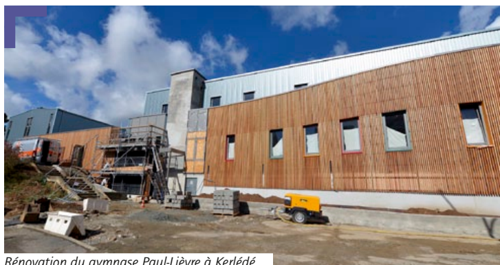
Rénovation du gymnase Paul-Lièvre à Kerlédé
