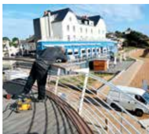
▲ Travaux de rénovation de l'esplanade de M.-Hulot, quartier de Saint-Marc.
