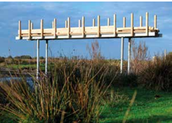
▲ Passerelle en cours de construction au port du Vivier.
