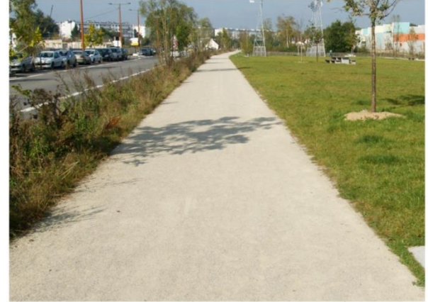
Sable stabilisé renforcé
